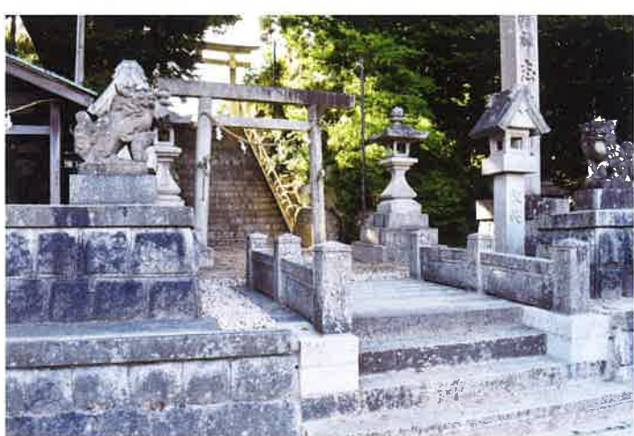
工事後の完成した石橋
