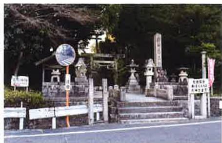
工事前の石橋
